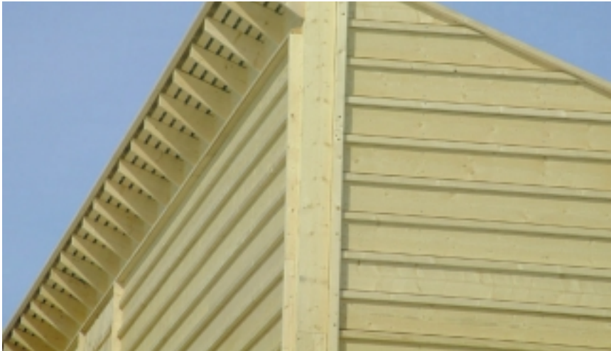
Nyoppført liggende lektepanel.
