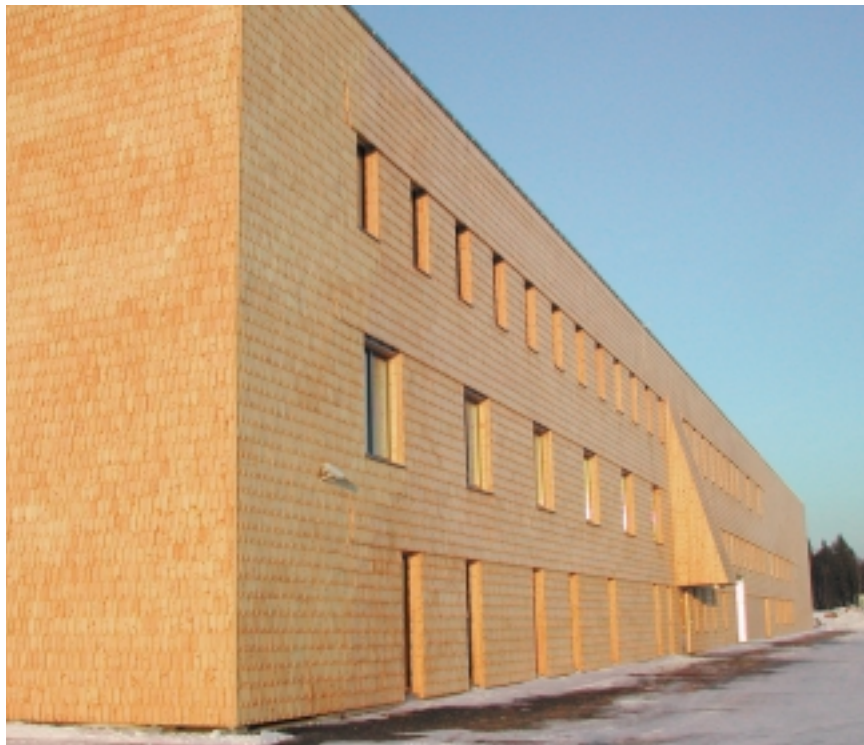
Kjerneved furu brukt som sponkledning. Rena Leir under oppføring.
