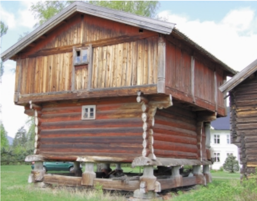
Vangestadloftet i Numedal. De opprinnelige furumaterialene er fra 1300 tallet. Bygningene er senere utvidet.
