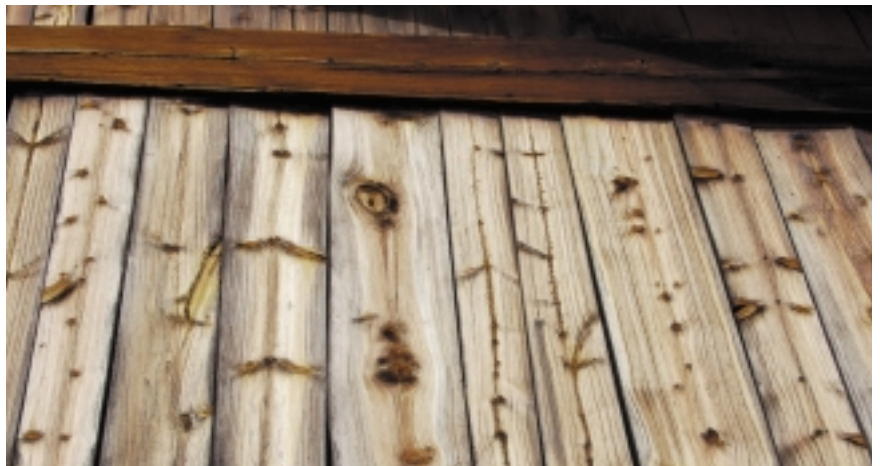
Furukledning brukt på stabbur med godt takutstikk.
