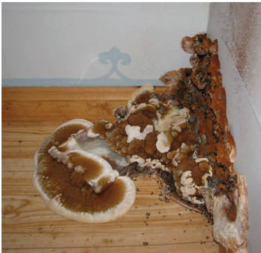
Figur 8. Fruktlegeme og mycel av ekte hussopp. Man kan også se de røde soppsporene over soppen. Dette er ofte første signal på ekte hussopp – rødt støv. Foto: Mycoteam AS.
