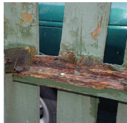
Figur 4. Liggende lekt i et gjerde har råteangrep i skjøt hvor regnvann har lett for å trenge inn. Foto: Treteknisk.
