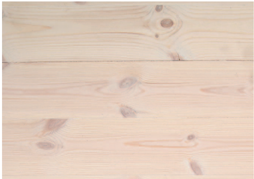
Lut- og oljebehandlet gulv.
