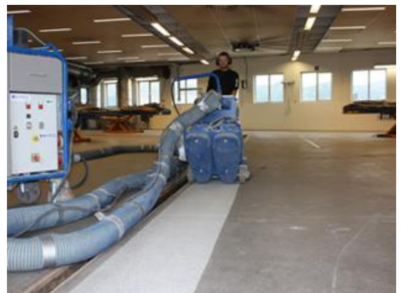
Blastring av stålglattet betonggulv
