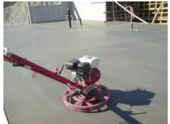
Stålglatting av betonggulv
